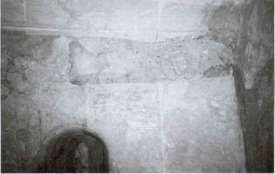
FIGURA 5. Absidiola sud, preparació del suport amb un folrat de paper seda.
